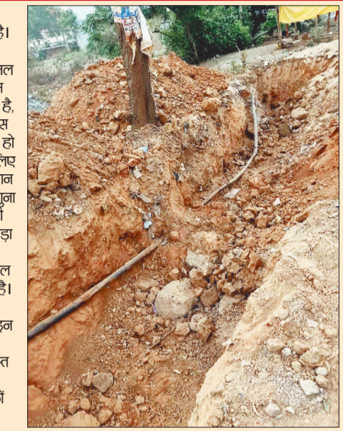
लटोरी बस स्टैंड स्थित नाली निर्माण कार्य के दौरान पानी सप्लाई लाइन
